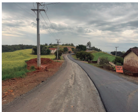
Pavimentação da Estrada Santo Antônio
