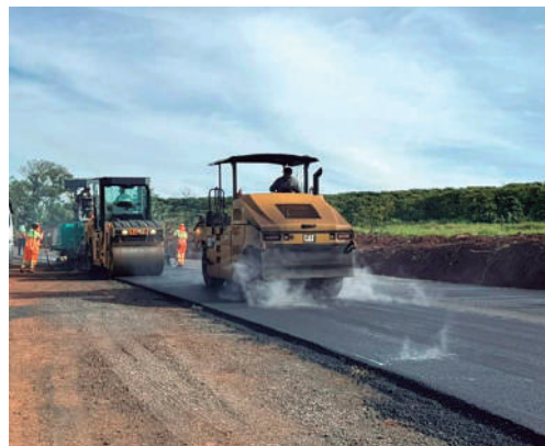
Rodovia Florindo Picoli recebendo nova pavimentação
