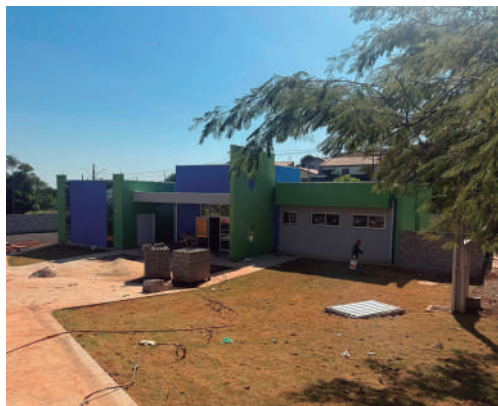
Obras da UBS do Residencial Cruzeiro em fase de conclusão
